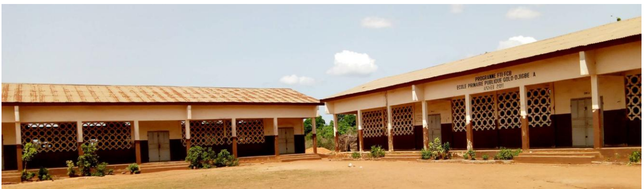
グループ A の 6 教室を擁する 2 棟の建物
