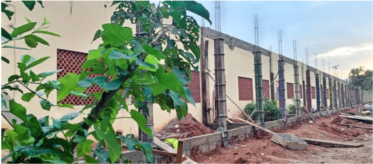
ベランダの柱のコンクリートが打設されました。
