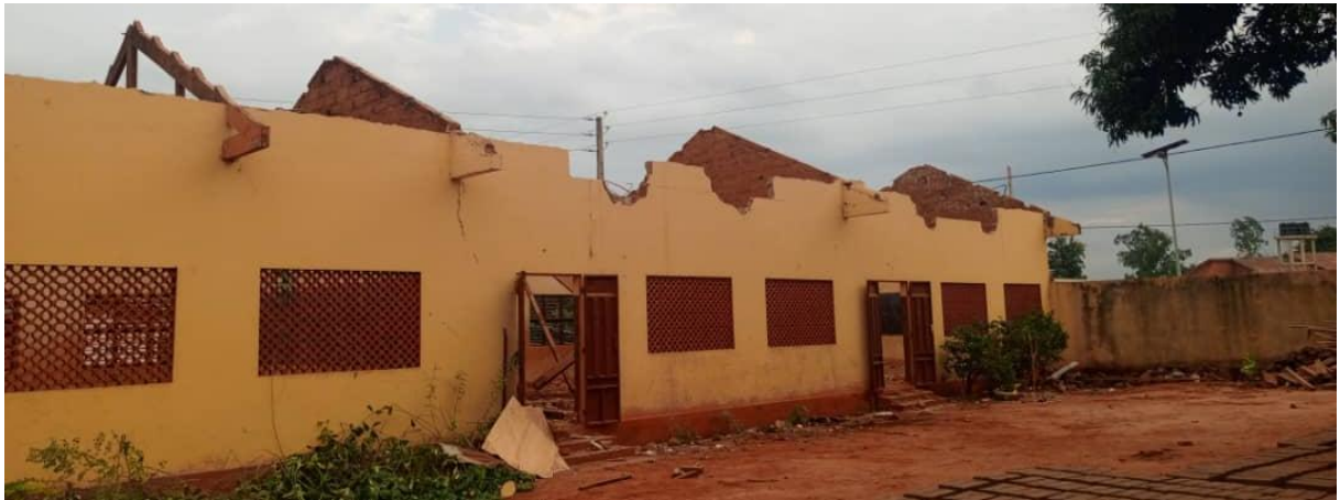
屋根の解体がほぼ完了しました。
