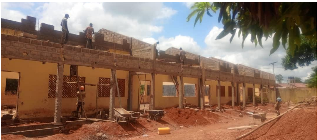
建設現場の風景
