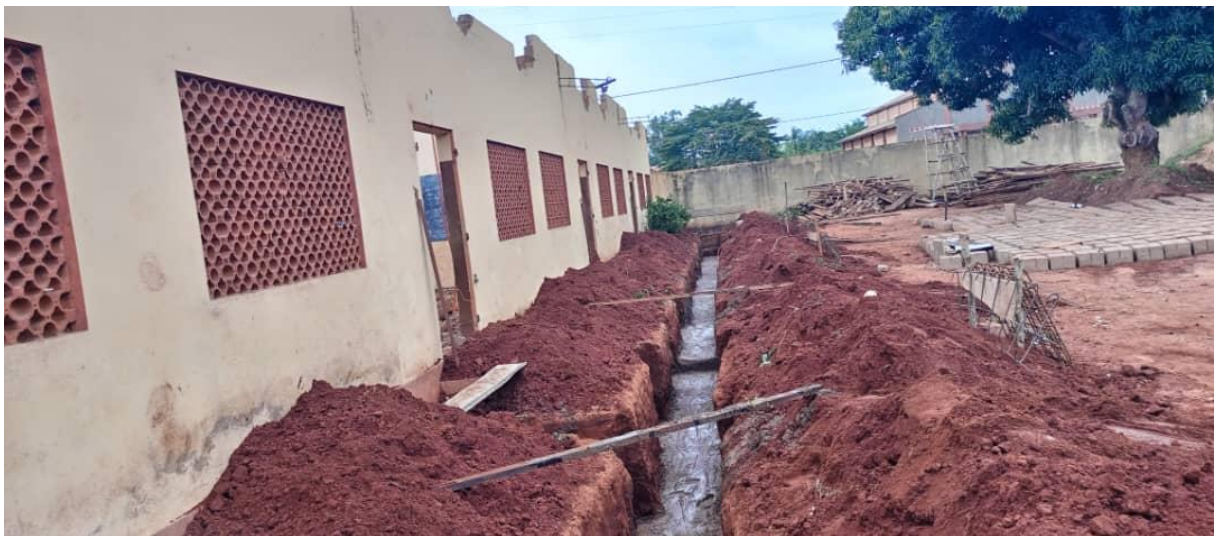
ベランダの基礎が敷設されます。
