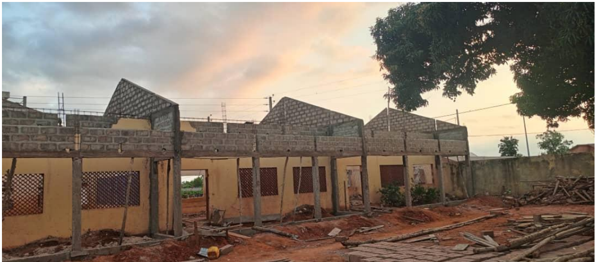
屋根をかさ上げするために、新しく積まれた妻壁
