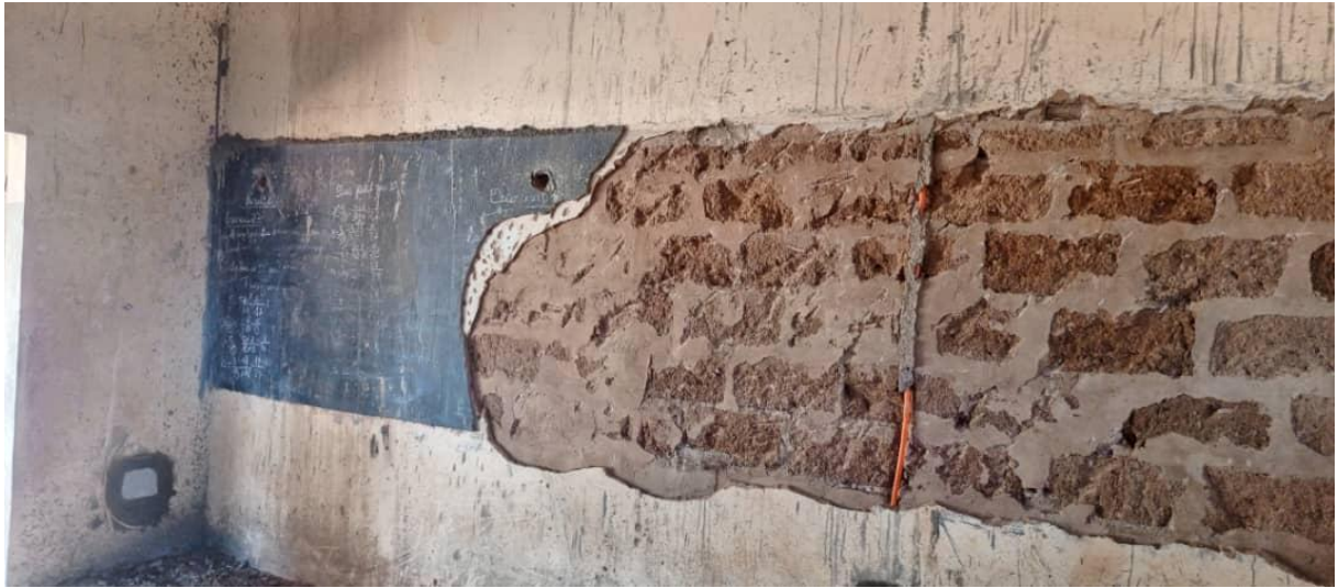
黒板の跡が残る間仕切り壁（改修前）
