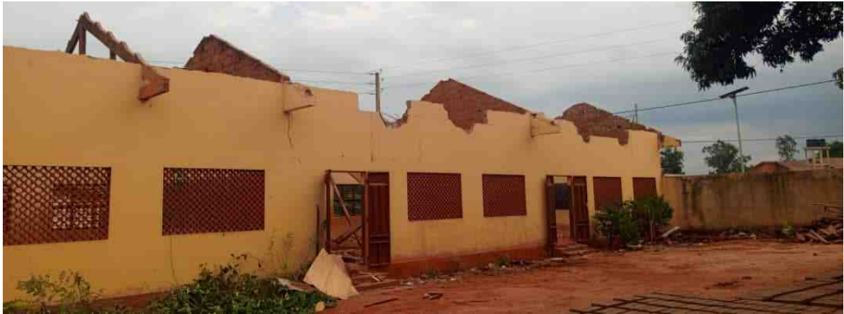
Démontage de la toiture presque terminé
