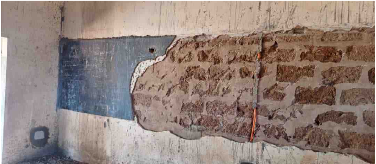
Cloison avec des restes de tableau noir - avant rénovation
