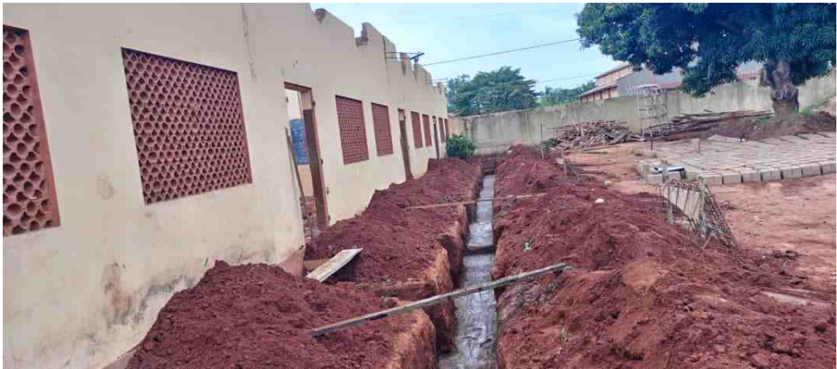
Les fondations de la véranda sont en cours de pose.
