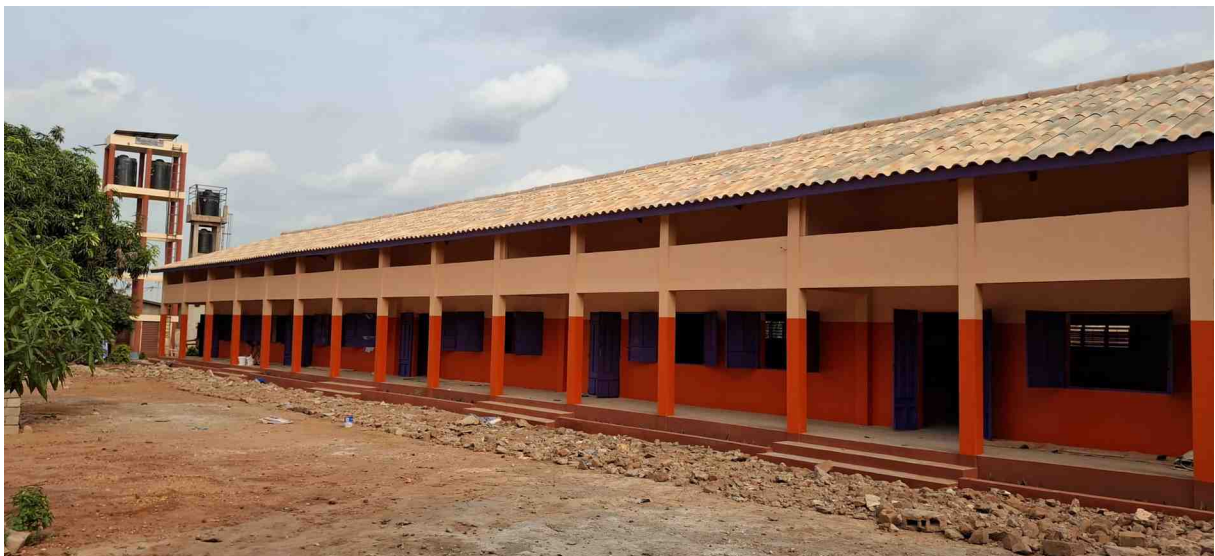
Le bâtiment rénové vu de face
