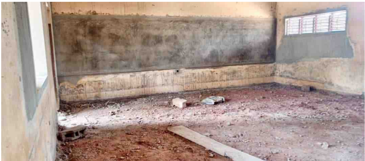
Entkernter Fußboden
