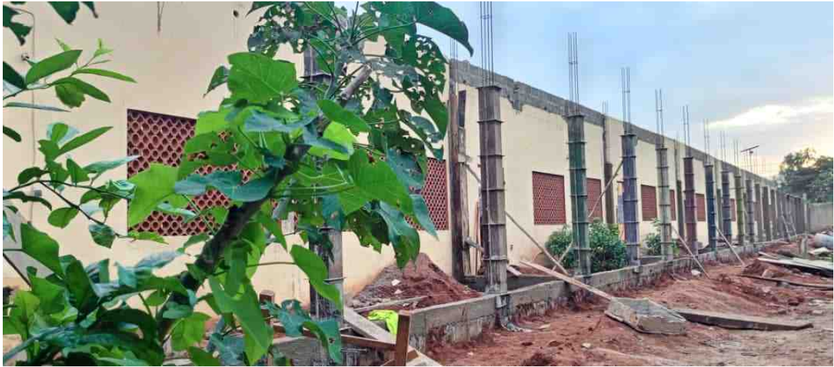
Die Pfeiler für die Veranda wurden gegossen
