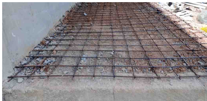
Un insert en fer a été incorporé dans le sol de la véranda.
