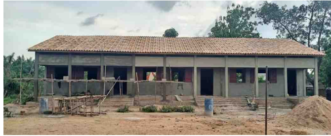
Der Dachfirst wurde geschlossen
