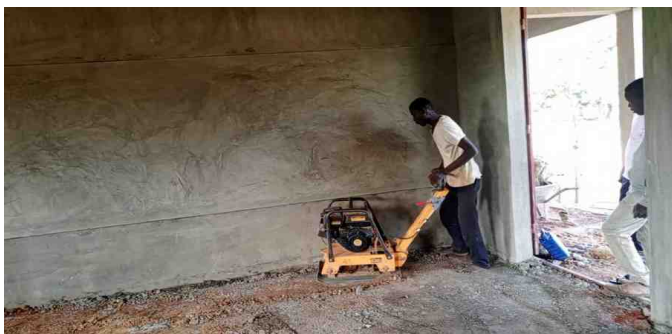
Der Böden wurden verdichtet und anschließend gegossen.
