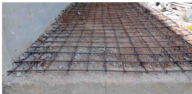
In den Boden der Veranda wurde eine Eiseneinlage eingebaut.
